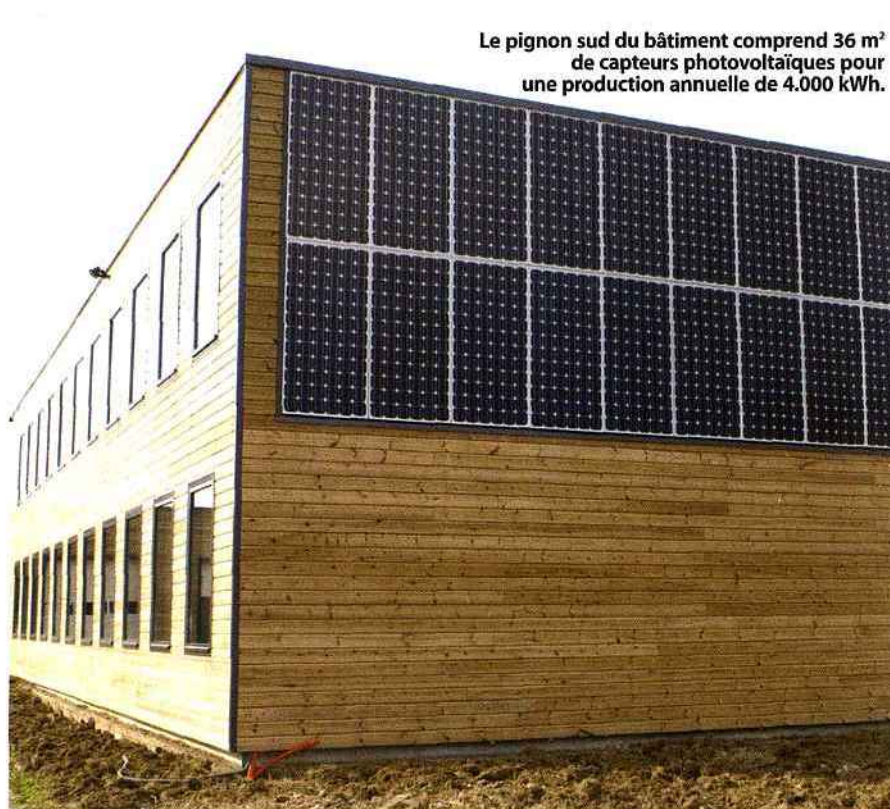
Les façades ont été isolées par l'extérieur de 100 mm de laine de verre, recouverts de bardage bois en pin lasuré.
