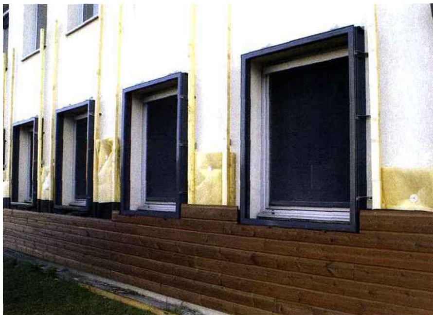
Les façades ont été isolées par l'extérieur de 100 mm de laine de verre, recouverts de bardage bois en pin lasuré.
