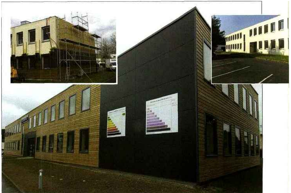
Le bâtiment du GESEC avant et après rénovation. Les lourdes modifications de l'enveloppe et des équipements thermiques divisent par quatre les besoins en énergie. L'affichage des étiquettes énergie et carbone signe le bâtiment.
